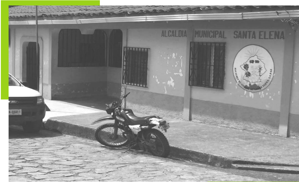
Instalaciones de la Municipalidad de Santa Elena, departamento de La Paz
